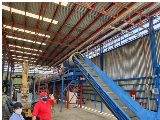
Planta tratadora de residuos en Islas Marías
