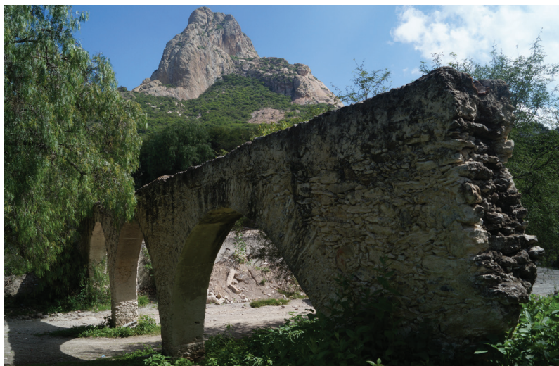
Antiguo Acueducto en el barrio La Fuente en Bernal.
